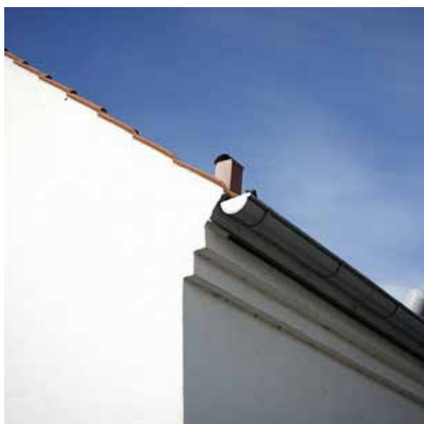
Referens: Minimalt taksutprång och profilmurad gesims i takfoten.
