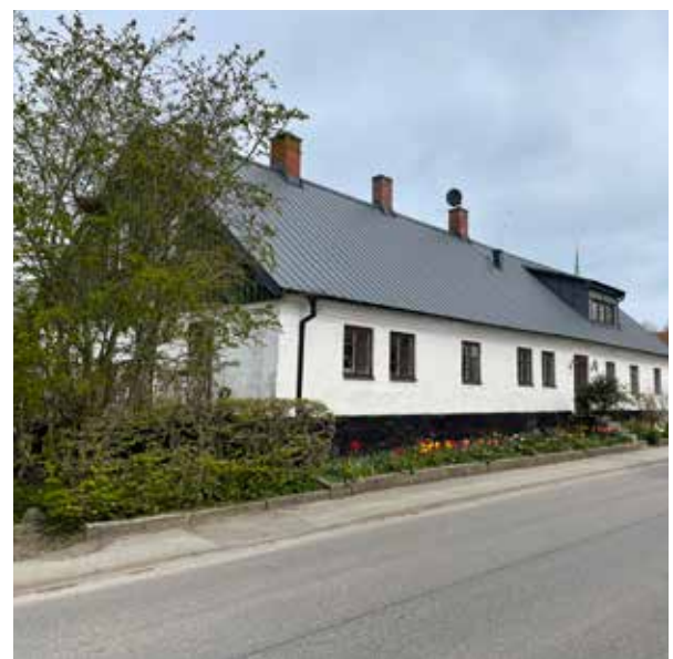
Referens: Sadeltak i plåt med gavelröste i trä. Murad takfot. Takkupa. Murade skorstenar i nock.
