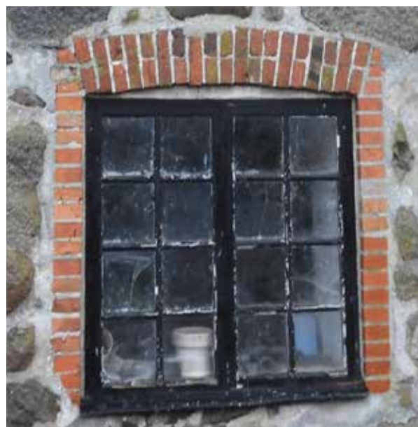
I gårdsbebyggelsen är tegelomfattande småspröjsade fönster i gjutjärn vanliga. Nya öppningar föreslås få liknande omfattningar.
