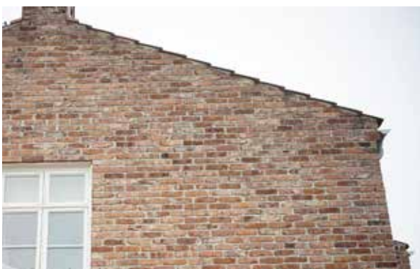
Referens: Återbrukat tegel, spröjsade träfönster. Inget takutsprång.
