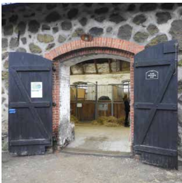
Befintliga portar i gårdsbebyggelsen ramas in av tegel.
